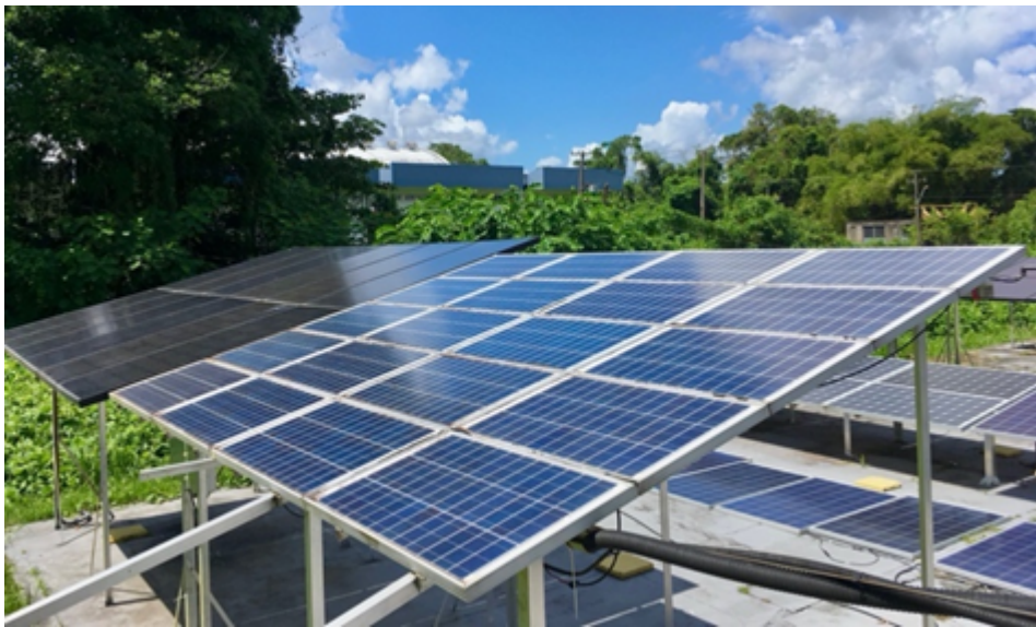
Figura 3.2 – Gerador fotovoltaico de 10 módulos SW245 da Solarworld.
